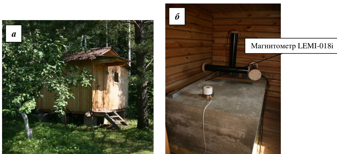
Рисунок 2.1 – Внешний (а) и внутренний (б) вид геомагнитного павильона на ГФО "Михнево".
