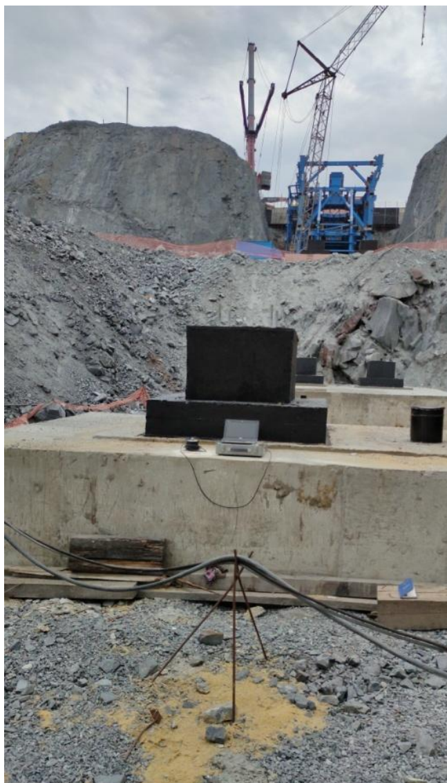
Рисунок 4.4 – Место размещения мобильной сейсмической станции в карьере Михайловского ГОКа
